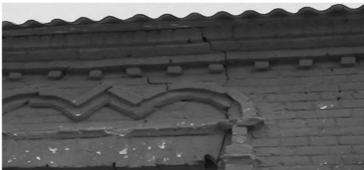
Рисунок 1 – Трещина в стене
